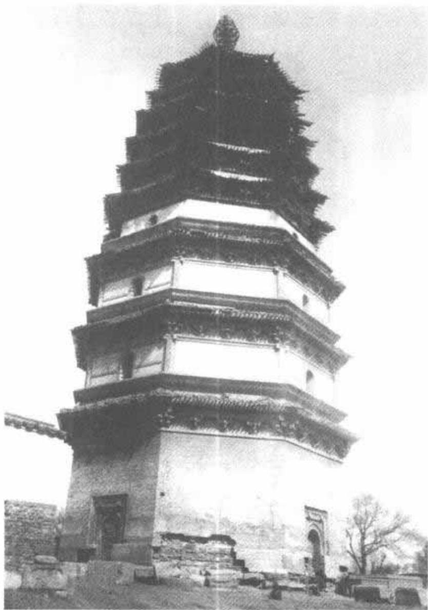
第 86 图 河北正定天宁寺木塔
