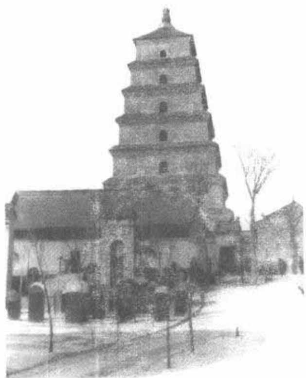
第24图 陕西西安慈恩寺塔(大雁塔)
