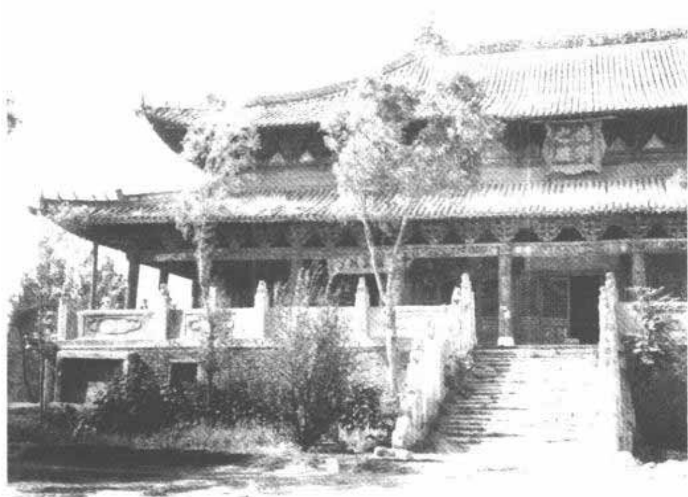
第109图 河北曲阳县北岳德宁殿
