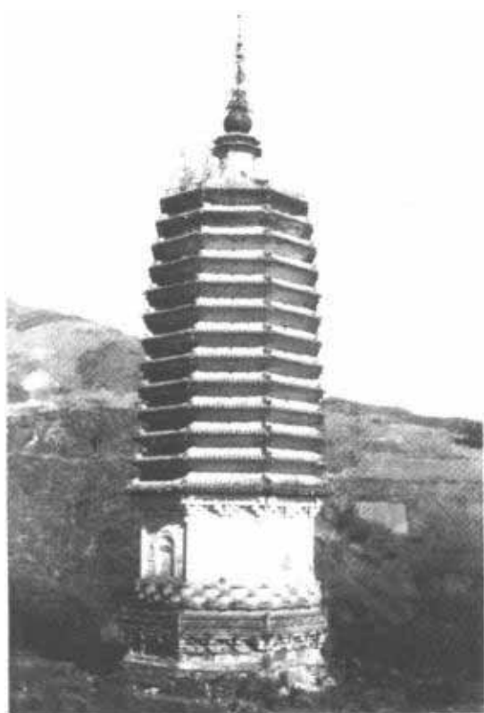
第 94 图 河北易县秦宁寺舍利塔
