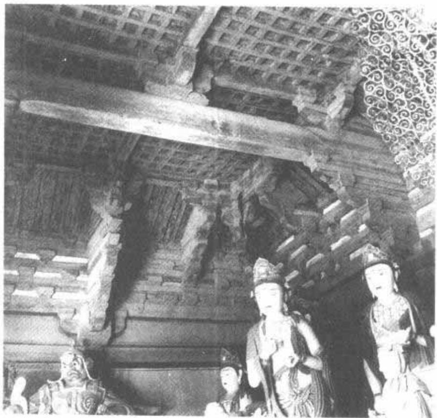
第 22 图 山西五台山佛光寺大雄宝殿内槽斗拱及月梁
